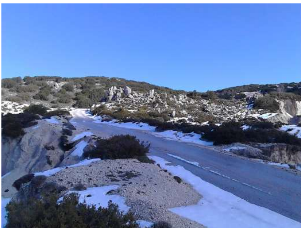
Φωτο 17. Υποψήφια θέση 1 ΧΥΤΥ της ΜοΠΑΚ Δ. Λευκάδας, «Αμμόκαμπος».
