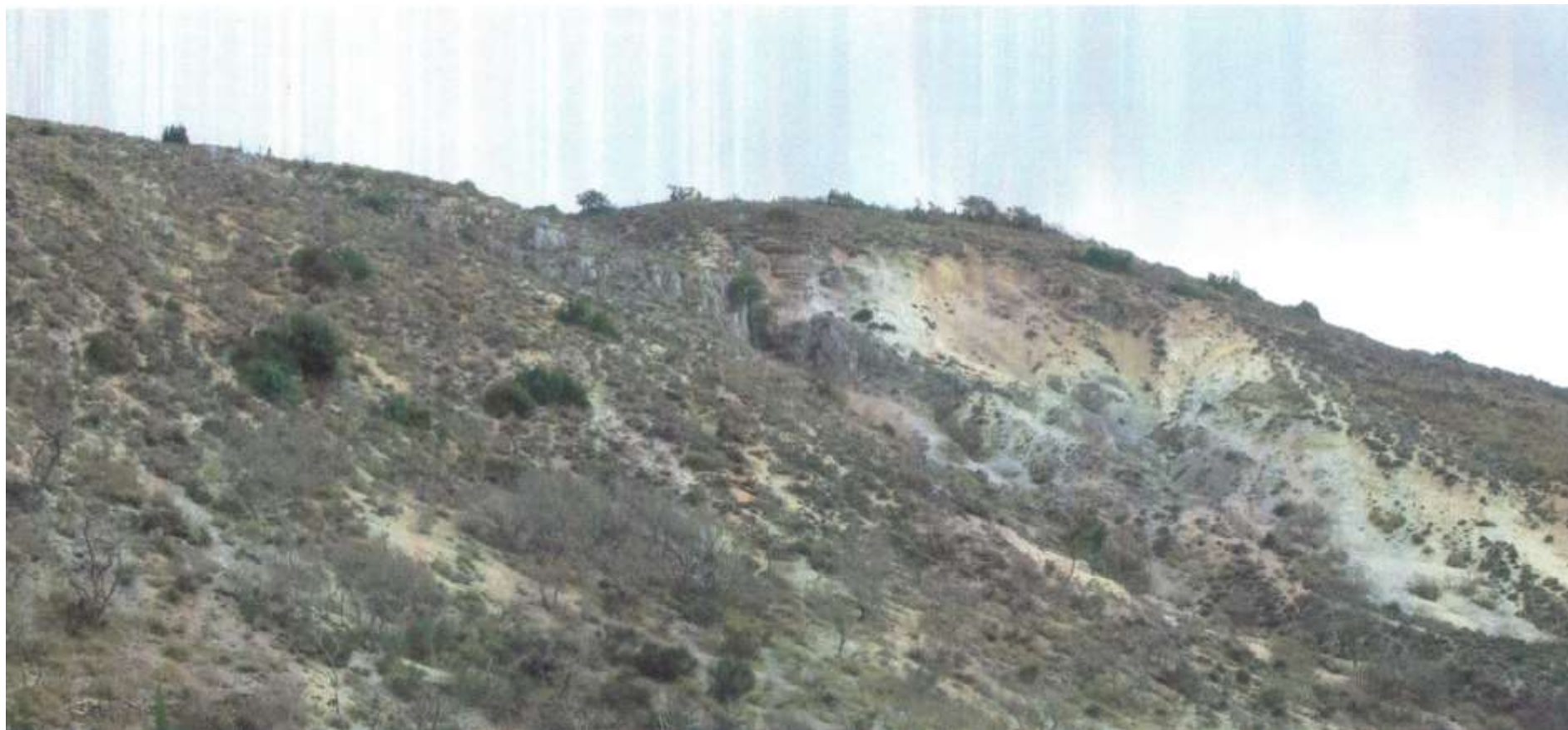
Φωτο 21. Άποψη της κατολίσθησης που έχει εκδηλωθεί στην προέκταση του ρήγματος προς ΝΔ. Η κατολίσθηση βρίσκεται σε απόσταση 250 μ. νότια της υποψήφιας θέσης 2 «Περδικοφωλιές» για την κατασκευή ΧΥΤΥ Δ. Λευκάδας.
