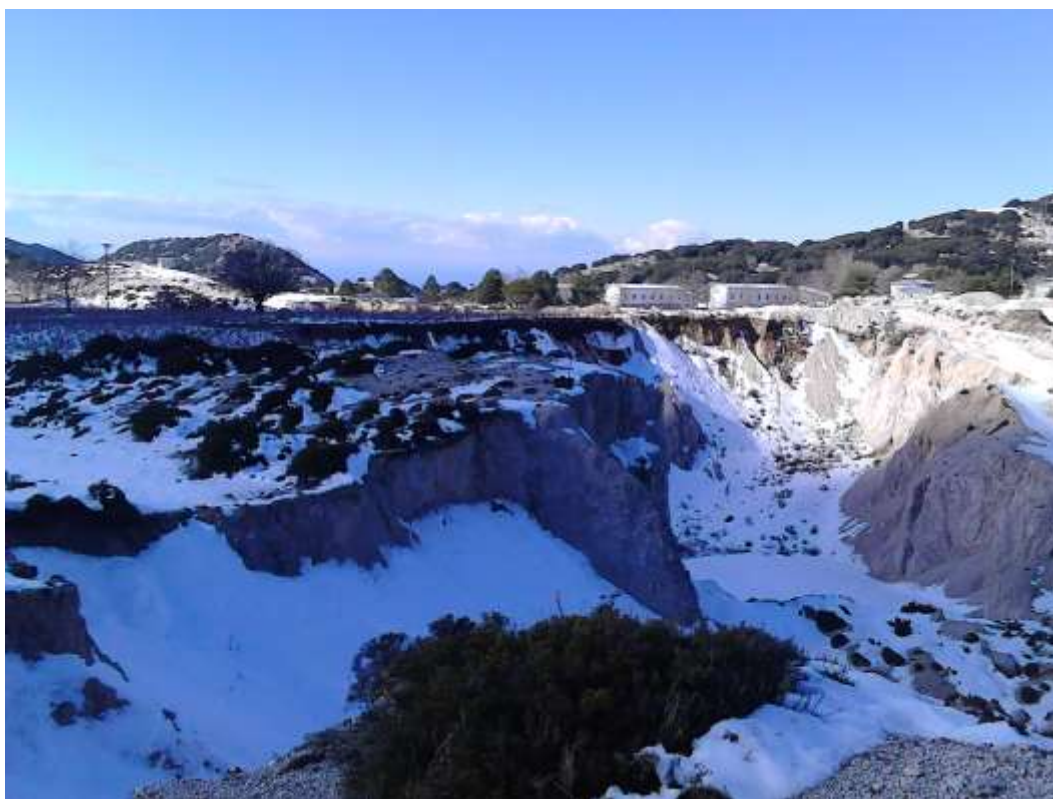
Φωτο 14. Υποψήφια θέση 1 ΧΥΤΥ της ΜοΠΑΚ Δ. Λευκάδας, «Αμμόκαμπος».
