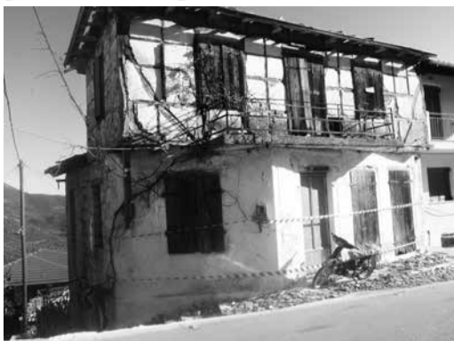
Το κατεδαφισθέν κτήριο του κ. Σαββίνου
