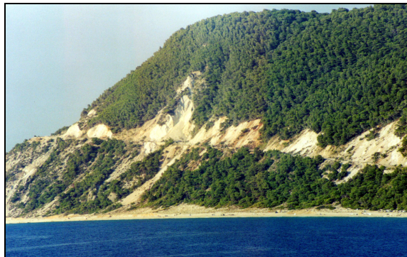
Σχήμα 8. Κατολισθήσεις – καταπτώσεις στο τμήμα του δρόμου Τσουκαλάδες - Άγιος Νικήτας που επεκτάθηκαν κατά το σεισμό του 2003.
